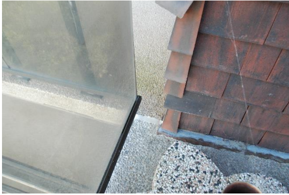
Voeg tussen de loodslab en het prefab balkon werd slordig opgekit. Lintvoegen staan open.
