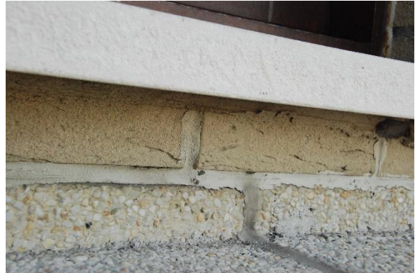
Openstaande voeg onder de raamdorpel is niet mooi dicht, ook de overgang tussen de twee vlakken.
