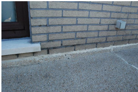
Mosvorming te zien op de voegen van het gevelmetselwerk en open stootvoegen.
