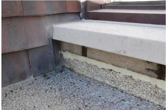
Voeg tussen de loodslab en het prefab balkon werd slordig opgekit. Lintvoegen staan open.
