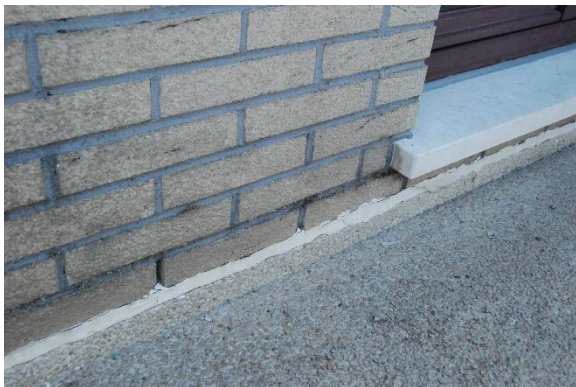
Mosvorming te zien op de voegen van het gevelmetselwerk en open stootvoegen.
