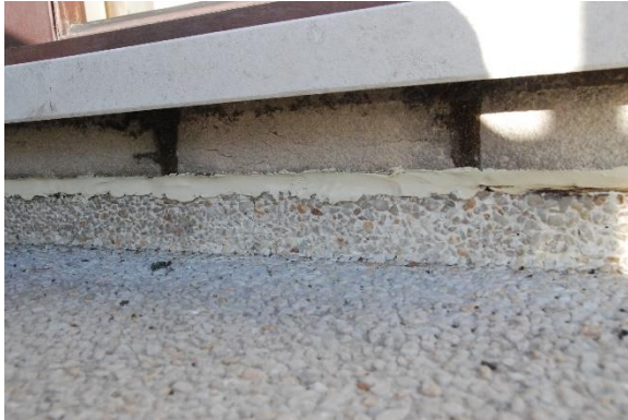
Niet opgevoegde lintvoegen.
