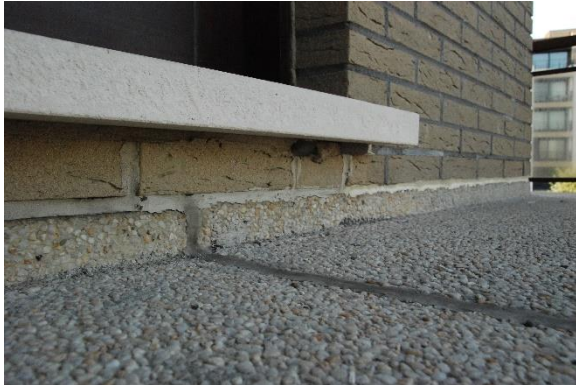
Mosvorming onder de dorpel en niet aansluitende elastische voeg.
