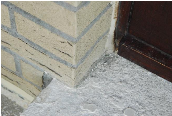
Openstaande voeg en slechte aansluiting tussen een bestaande en een nieuwe voeg.
