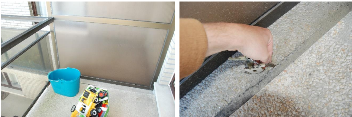
Niveaoverschil tussen twee balkons met elastische voeg die niet dicht is.
