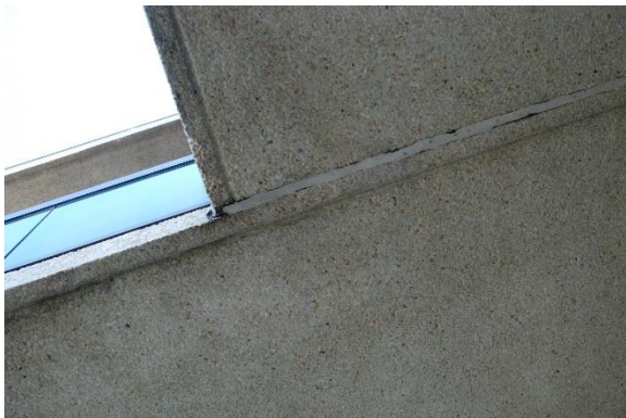
Niveaoverschil tussen twee balkons met elastische voeg die niet dicht is.
