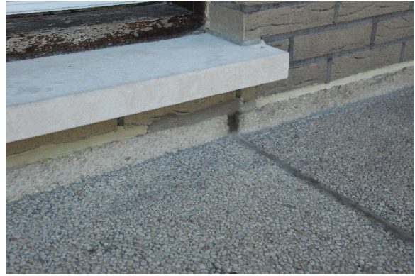
Openstaande voeg onder de raamdorpel is niet mooi dicht, ook de overgang tussen de twee vlakken.
