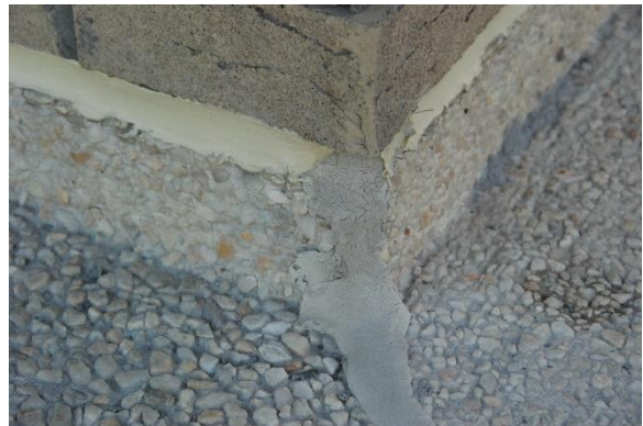
Openstaande voeg en slechte aansluiting tussen een bestaande en een nieuwe voeg.
