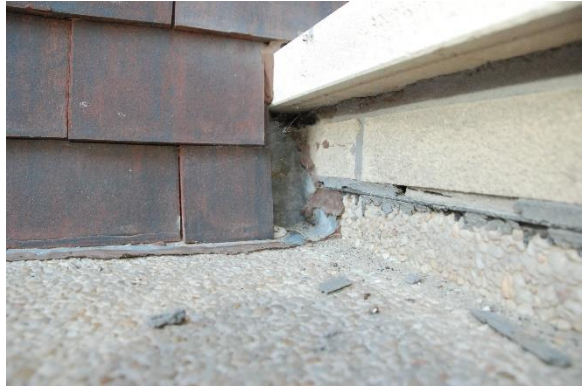
Voeg tussen de loodslab en het prefab balkon werd slordig opgekit. Lintvoegen staan open.
