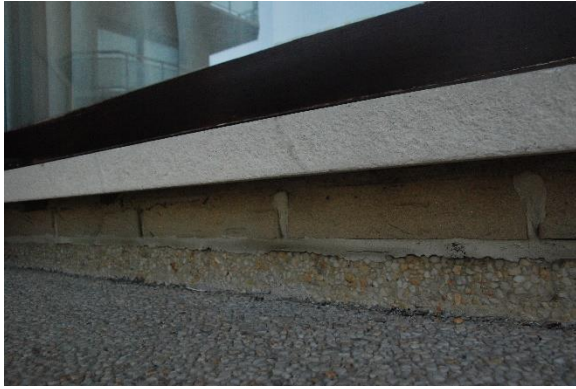
Openstaande voeg onder de raamdorpel is niet mooi dicht, ook de overgang tussen de twee vlakken.
